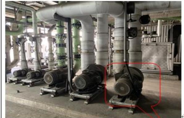
40HP 冰水泵浦增設變頻器控制運轉轉速
