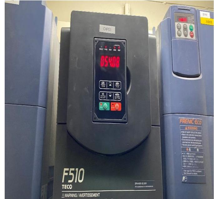
節能改善工程於111年10月完工，裝置變頻器及檢測數據所示，冰水泵平均耗電**19.3kW**，全年運轉時數以8,760小時計算，改善後冰水水泵全年耗電量**169,068kWh/年**，節省用電**63,948kWh/年**節能效益**16.2萬元/年**。(平均電價以2.53元/kWh計算)
