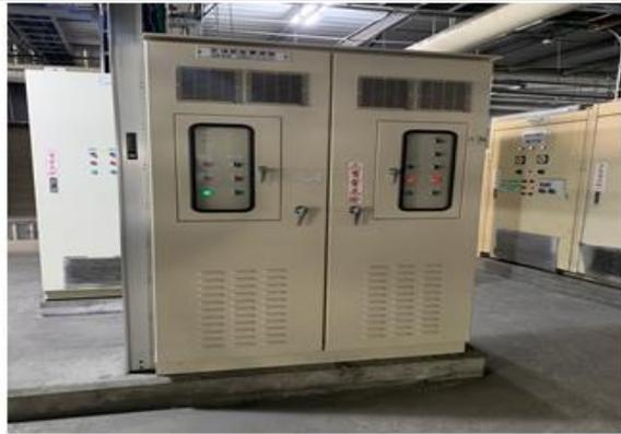
冰水泵浦變頻器預計安裝於既有節能盤內
