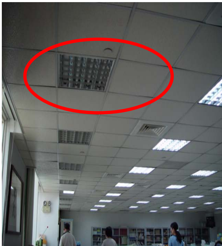
靠窗部份引用自然光 (台南市政府)
