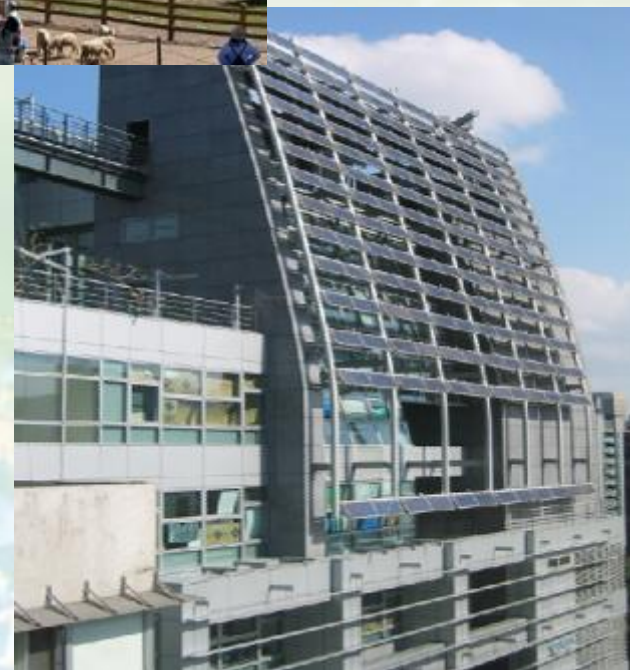
台北市 福安紀念館 設置容量：19.8kWp
