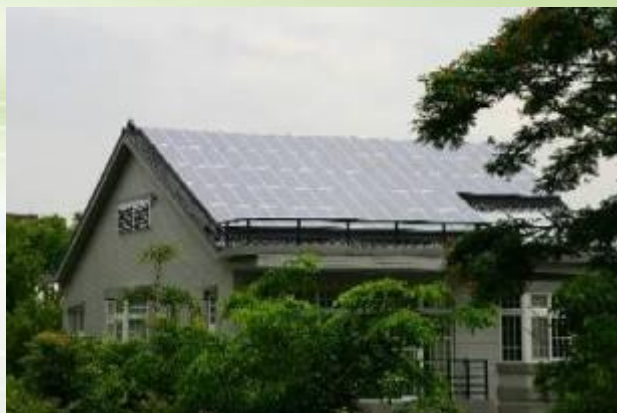
高雄縣湖內鄉住宅 設置容量：6.6kWp
