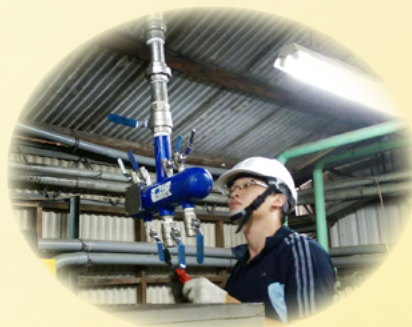
▲ 節能技術服務 空壓機效能檢測
