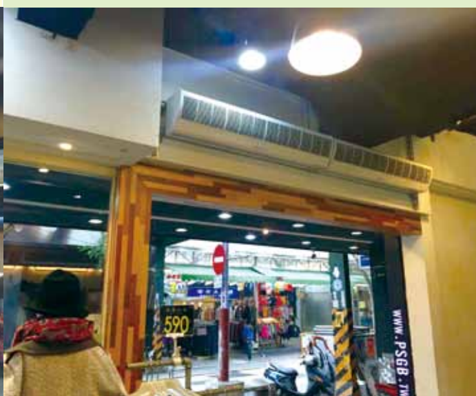
改善後-設置空氣簾阻隔冷氣外洩
