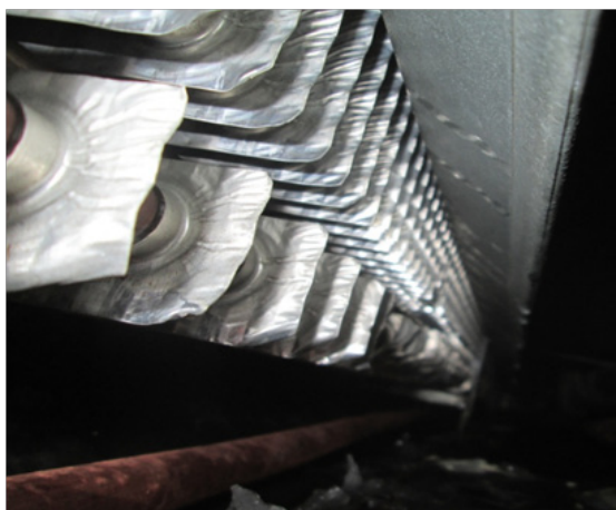
圖 3 冷凍臥櫃使用熱氣除霜後之蒸發器外觀
