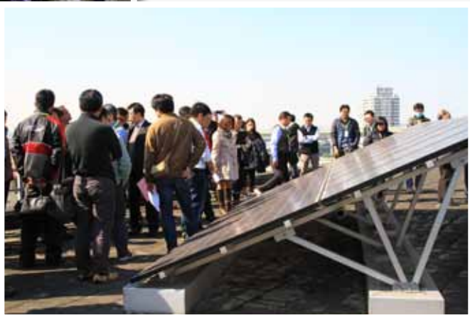
▲現場觀摩屋頂太陽能發電現況
