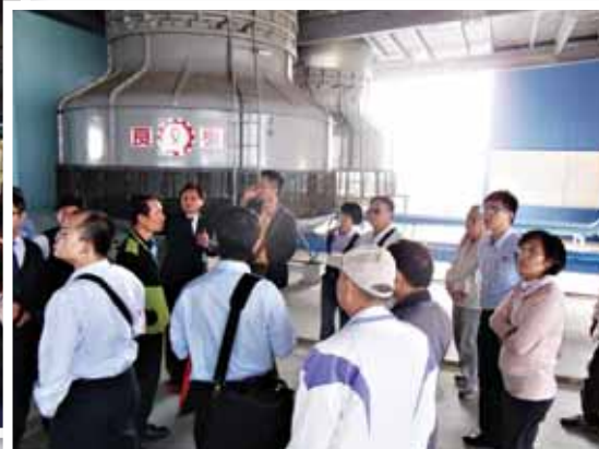
▲大康公司現場解說水冷式中央空調節能改善措施 (11/27 示範觀摩活動－大康織機)
