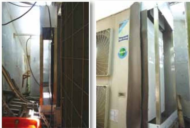
圖6 便利超商分離式空調系統(噴霧式模組)
