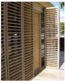
建築物外表可調式隔熱/光百葉窗
