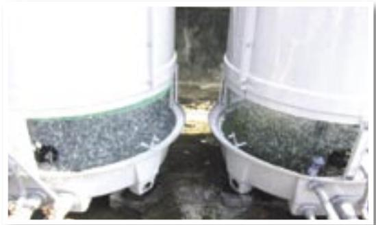
圖4 臭氧處理可有效抑制菌藻的滋生，維持循環水質的穩定
