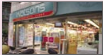
屈臣氏藥妝店，裝設鋁框玻璃窗縮小門面並加裝自動門
