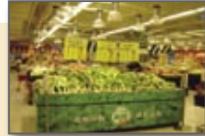
賣場電子式日光燈及果菜區臥式 產生櫃重點照明採用複金屬燈
