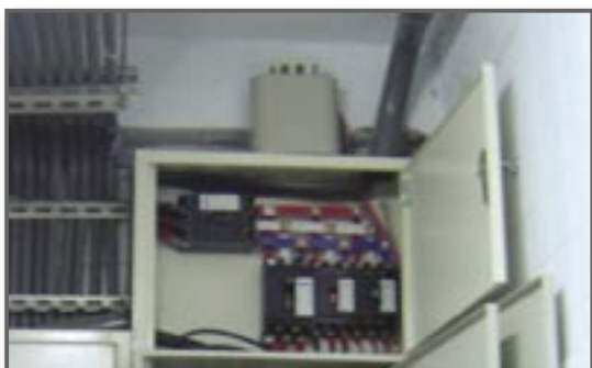
配電系統採用低壓進相電容器 提高功率因數，改善線路壓降
