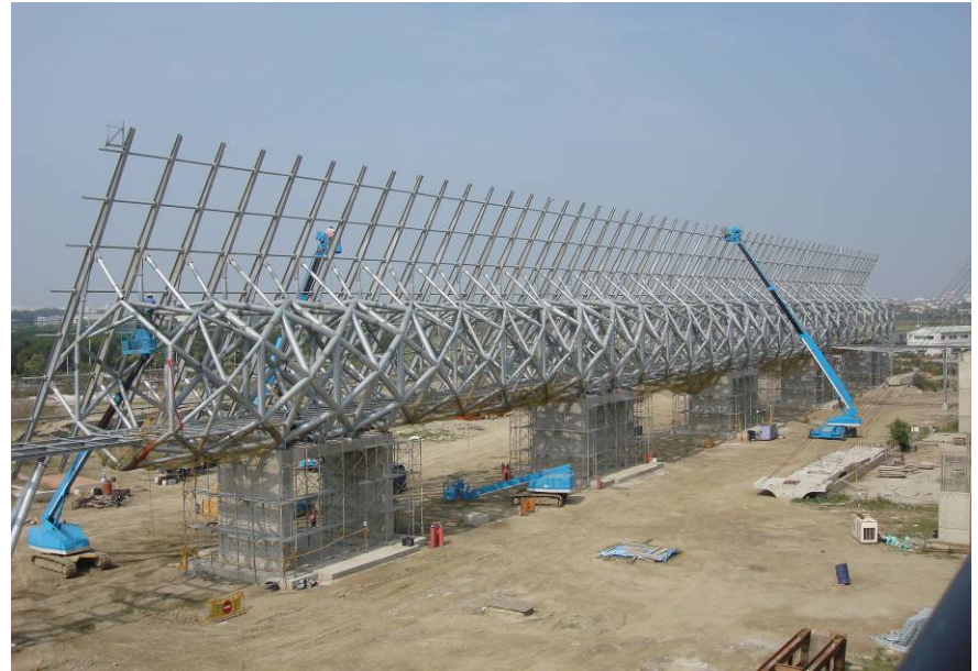
光電雲牆基座結構體目前組立現場照片(左:前方，右:後方)
