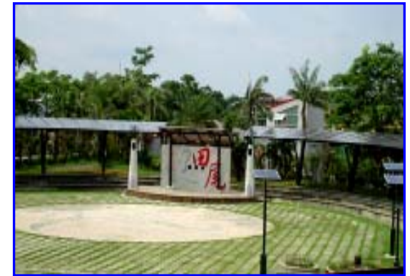
田尾鄉公所怡心園遊客中心廣場 15.4kWp
