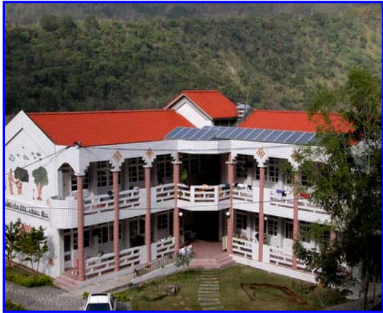
雲林縣水林國小3.36kWp
